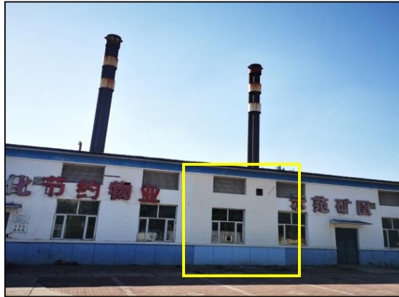
图 2-4 本项目拆除并恢复墙体现状
